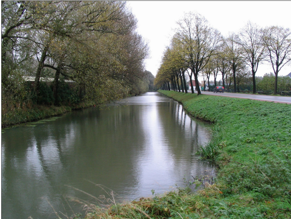
Figuur 7. De Meer ter hoogte van de N833. Vermoedelijk een voornamelijk gegraven watergang ten dele aangelegd in een restgeul van de crevasse van Hennisdijk.
