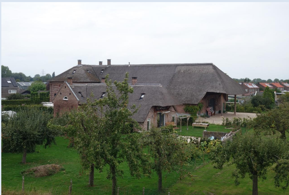
Figuur 217. Twee boerderijen van het T-vormige type met middenlangsdeel aan de zuidrand van Heesselt (foto: MAB / C. J. Frank). Beide gebouwen hebben boven de achtergevel een voor de regio typerend overstek.
