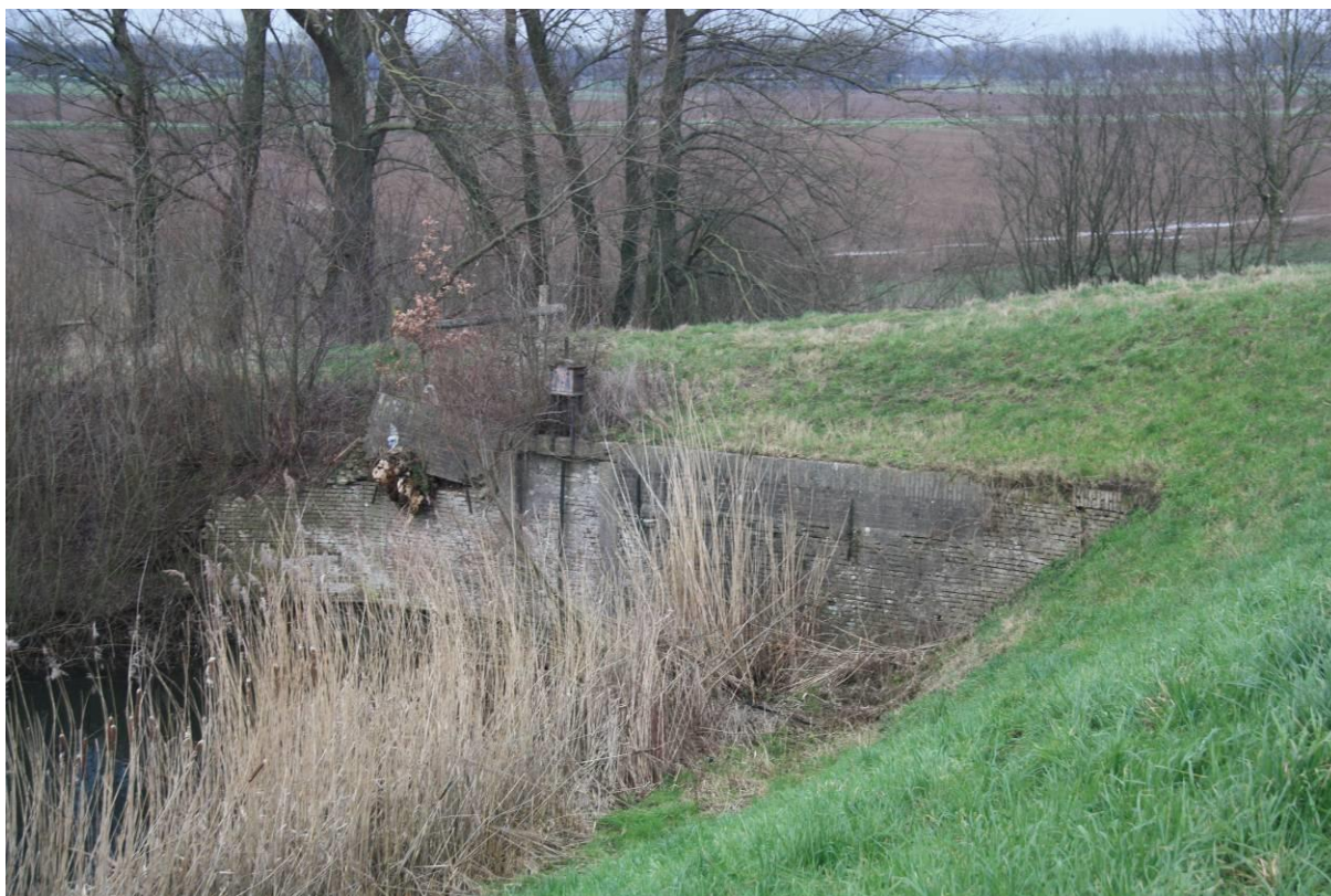
Figuur 116. Restanten van het Herwijdense stoombemaal bij Fort Vuren.
