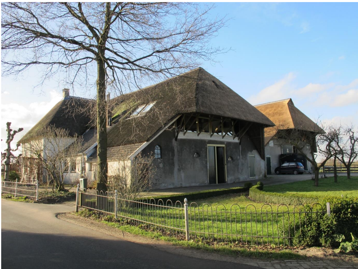
Figuur 189. Overstekende kappedeelten van de boerderij en schuur aan de Bommelweg 2a (foto: MAB / C.J. Frank).
