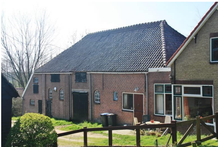
Figuur 98. Aan het eind van de 19e en het begin van de 20e eeuw worden de schuren steeds meer van een hoge zijgevel voorzien om een hoge inrijpoort te verkrijgen. Vaak zit hierboven nog een hooiluik. Zuiderlingedijk 93, Spijk.
