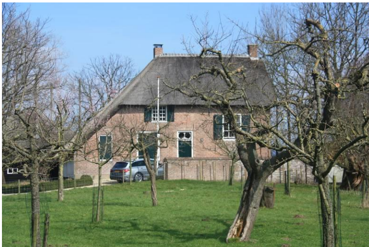
Figuur 94. In de loop van de zeventiende eeuw ging men het woongedeelte naar één kant uitbouwen. Hierdoor ontstond een asymmetrisch gebouw dat de bouwhistorici een krukhuis noemen. In de uitbouw werden vaak een kelder met daarboven een opkamer ondergebracht. Krukhuisen zijn zeldzaam in Lingewaal, maar de boerderij Den Ouden Dijk (1651) aan de Katerdam in Herwijnen is een mooi voorbeeld. Den Ouden Dijk in Herwijnen.
