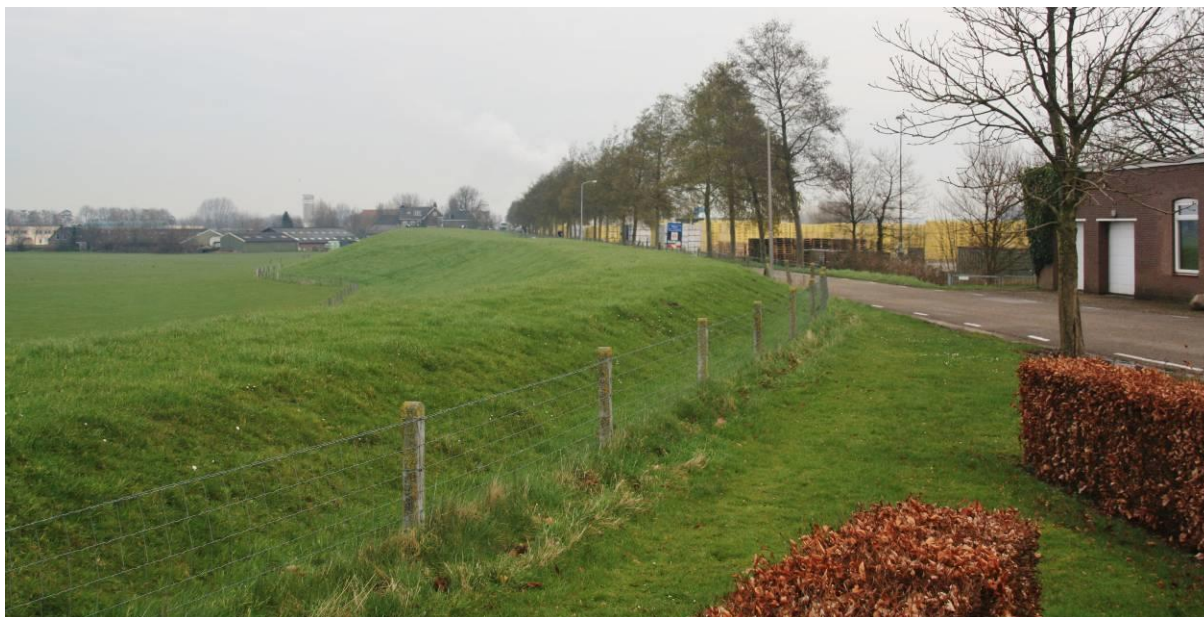
Figuur 102. De Nieuwe Dijk in Vuren, een inlaagdijk die in 1771 bandijk werd.
