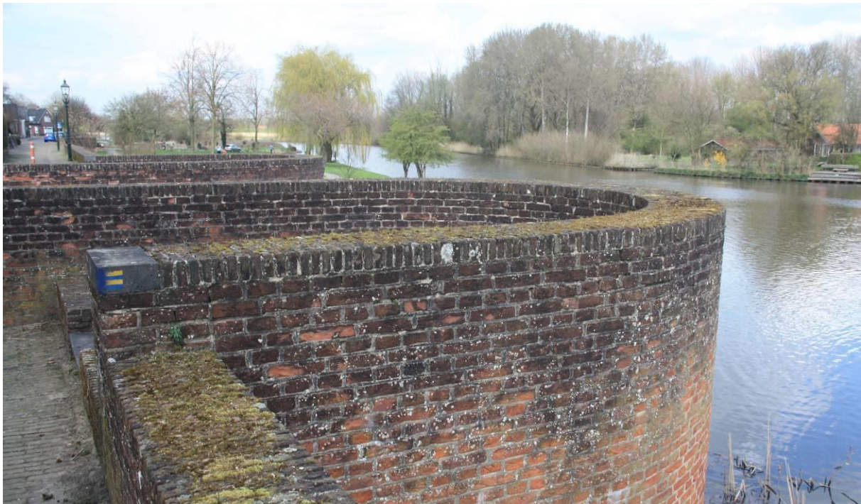
Figuur 117. De deels gereconstrueerde Waterpoort van Asperen.
