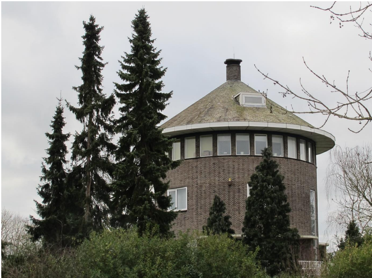
Figuur 163. Landhuis in expressionistische stijl aan de Lingedijk 1 (foto: MAB / C.J. Frank).
