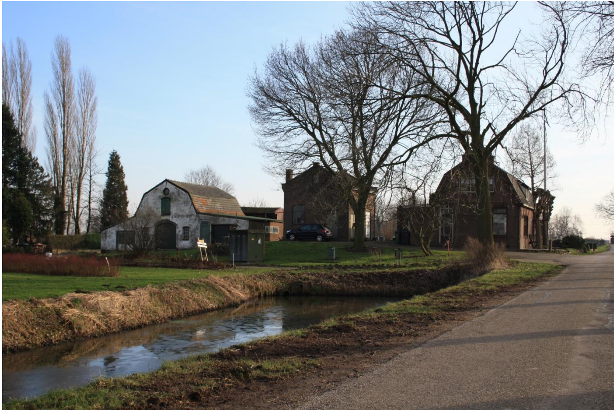
Figuur 32. Het elektrisch gemaal aan De Paay verving in 1927 het stoomgemaal dat hier in 1868 werd gebouwd (foto: RAAP / S. van der Veen).
