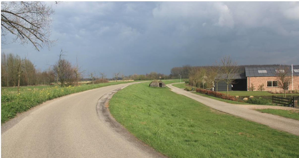
Figuur 103. Het hulpgat (overlaat) in de Zuiderlingedijk bij het Fort aan de Nieuwe Steeg.
