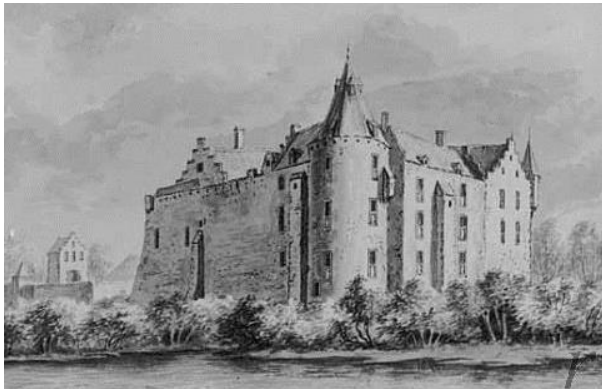
Figuur 124. Twee tekeningen illustreren de verandering van Kasteel Merkenburg. Hierboven een tekening van A. Rademaker uit ca 1710 naar een ouder origineel.
