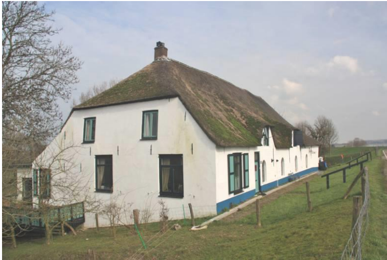
Figuur 93. Het hallenhuis is een rechthoekig gebouw dat door de ankerbalkgebinten in drie beuken wordt verdeeld. Woongedeelte en bedrijfs gedeelte zaten onder één dak. Waaldijk 120 is een voorbeeld van een hallenhuis.
