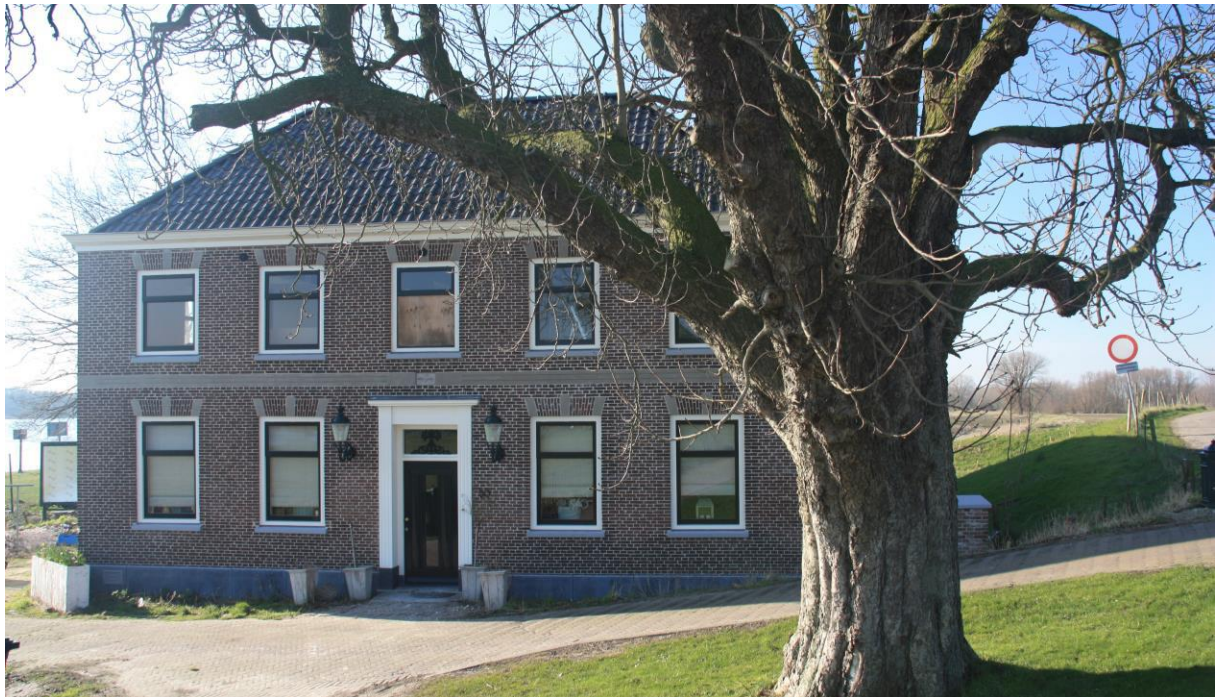
Figuur 105. Waaldijk 50 in Herwijnen is een buitendijks gelegen 17e-eeuwse boerderij waar omstreeks 1900 een extra, hoger voorhuis tegenaan is gebouwd, waarschijnlijk als aanpassing aan de hogere waterstanden op de Waal.
