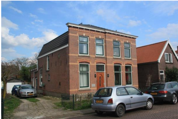
Figuur 136. De in 1912 gebouwde pastorie van de gereformeerde kerk van Asperen aan de Middelweg.
