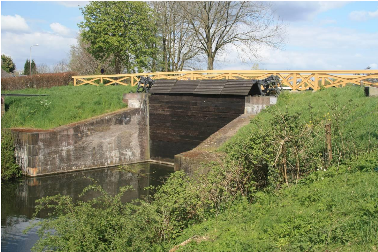
Figuur 118. De inundatiesluis in de zuidelijke Lingedijk bij Asperen.
