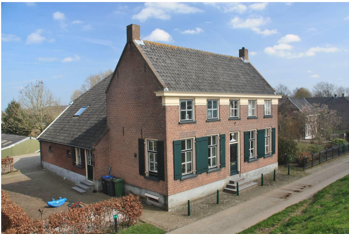
Figuur 99. Voorbeeld van een hooghuis aan de Onderweg in Herwijnen: stenen trappen bij de voor- en zijdeur en hooggelegen woonvertrekken in het voorhuis.
