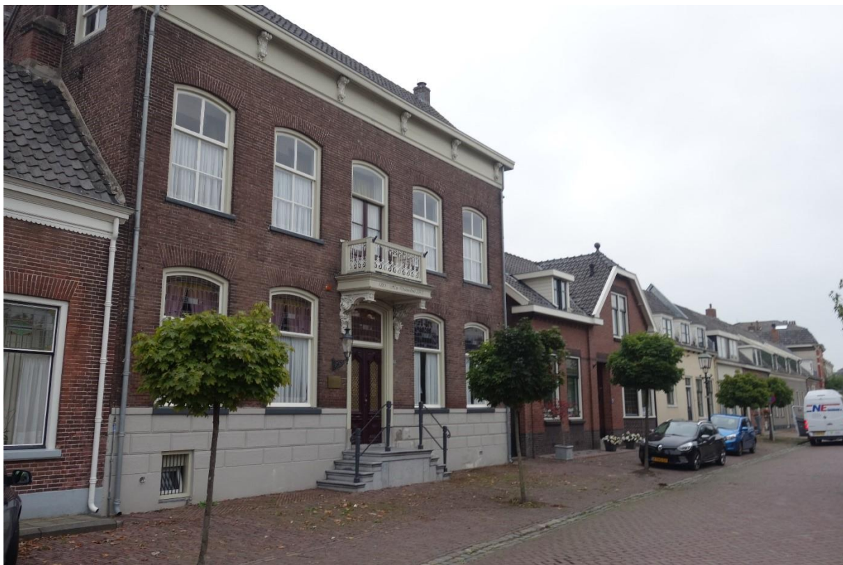
Figuur 156. Aaneengesloten bebouwing in de Voorstraat in Asperen (foto: MAB / C.J. Frank).
