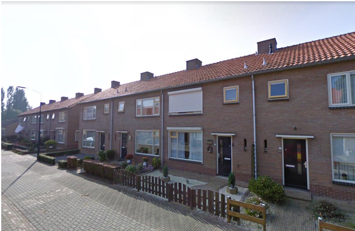
Figuur 182. Blokken geschakelde woningen uit de vroege naoorlogse periode aan de Karel Doormanstraat in Hellouw (foto: MAB / C.J. Frank).
