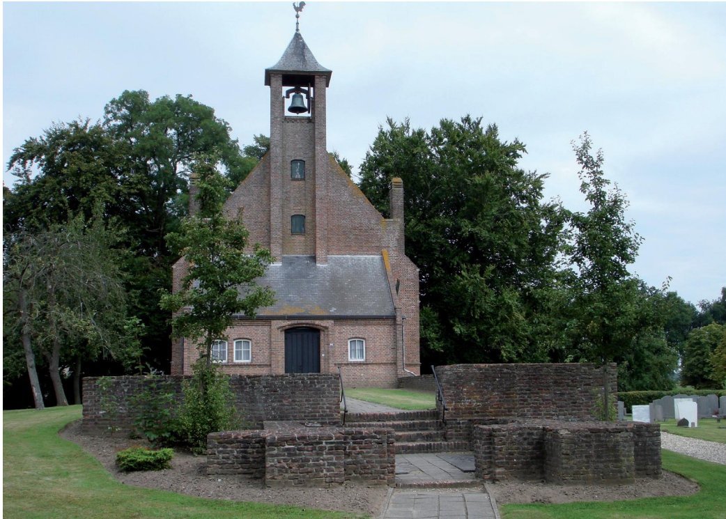
Figuur 11. Van de kerk van Nederhemert-Zuid zijn de funderingen van de laat-middeleeuwse voor-ganger nog zichtbaar.
